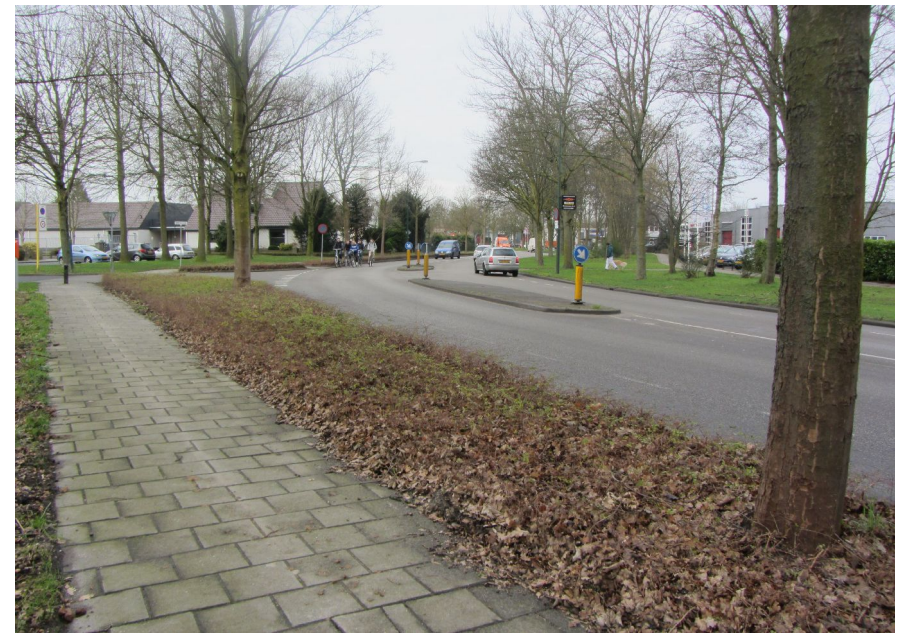
I.p.v. dit voetpad kan hier een fietspad komen! (nabij Emmerschans)
