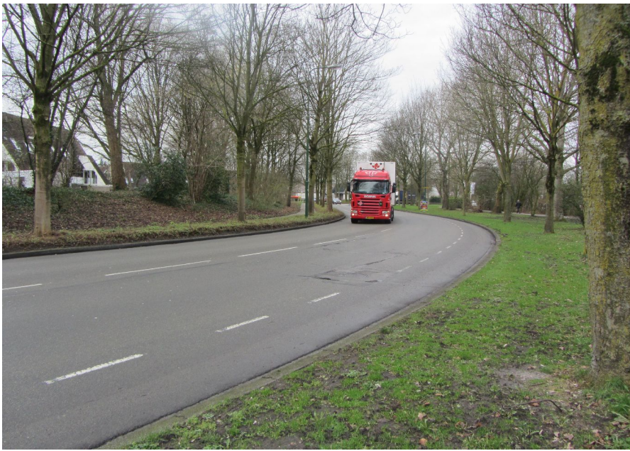
Door het vele zware vrachtverkeer is het voor fietsers levensgevaarlijk
