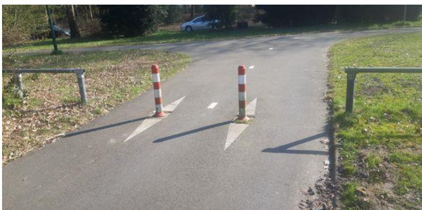
6] Rondweg West: doorgang te smal, slechts 1m.
